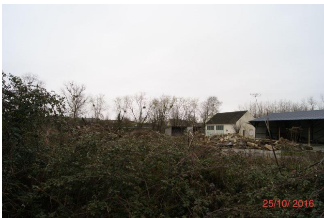
Vue 4 : terrain et construction à démolir, depuis haie coté sud
