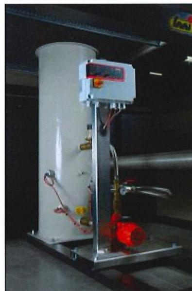
Des jeux de vannes permettent d'isoler les différents éléments afin de faciliter la maintenance de ceux-ci.
