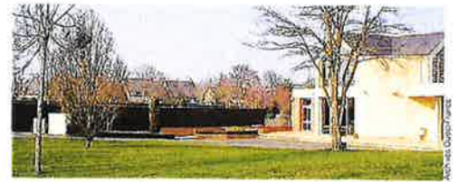
Le Crématorium de l'Anjou, situé dans une zone résidentielle de Montreuil-Juigné.
