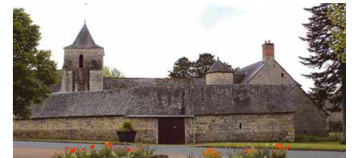
Des travaux de restructuration du presbytère de Charcé-Saint-Ellier-sur-Aubance sont prévus.
