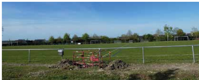
D'importantes tranchées ont été creusées à l'emplacement des nouveaux poteaux d'éclairage.
