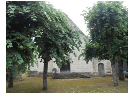
Église de l'ancien Prieuré Saint-Aubin Les Alleuds
