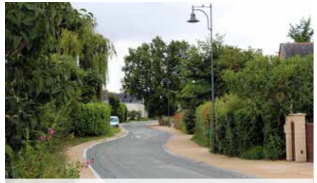
Ces travaux d'ampleur sont désormais terminés.
