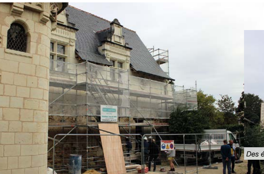
Plusieurs mois de travaux sont nécessaires pour cette rénovation.
