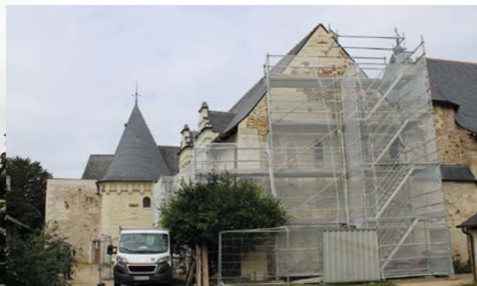
Des échafaudages importants ont été installés.
