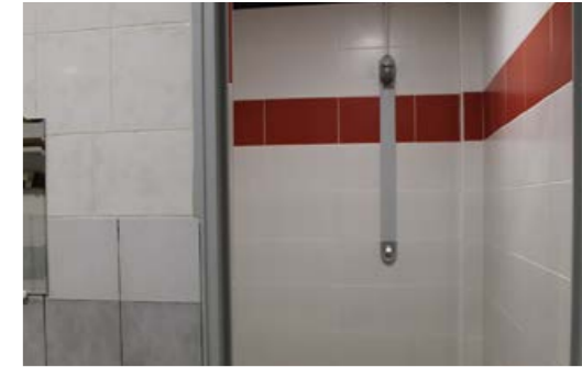
Les espaces douches de 4 vestiaires ont été refaits à neuf.
