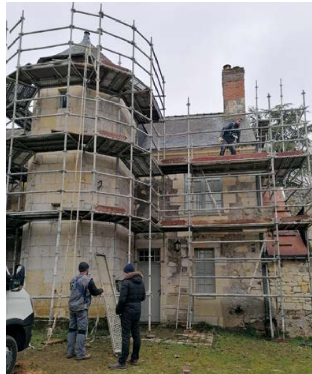
L'ampleur des travaux a nécessité l'installation d'un échafaudage conséquent.
