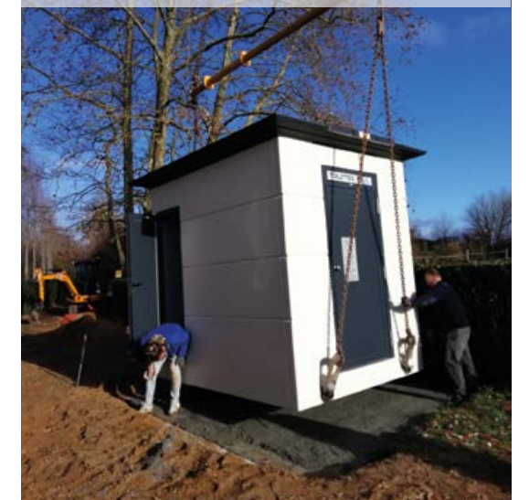
Une grue est venue déposer la nouvelle cabine de sanitaires.
