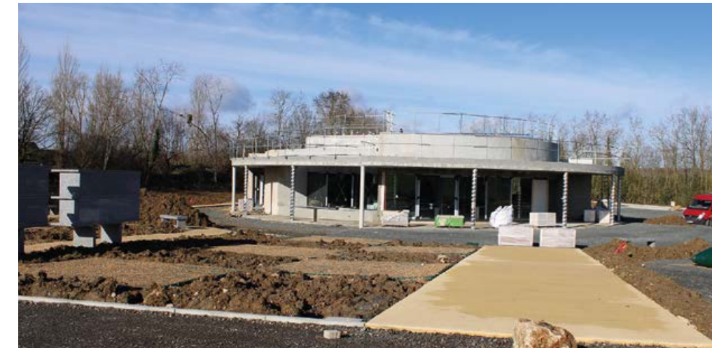
Désormais ce sont les aménagements intérieurs et extérieurs qui se poursuivent.
