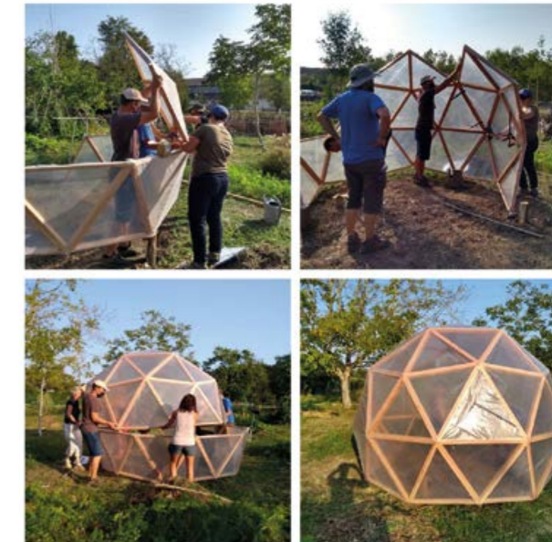
La construction du dôme par les jardiniers.
