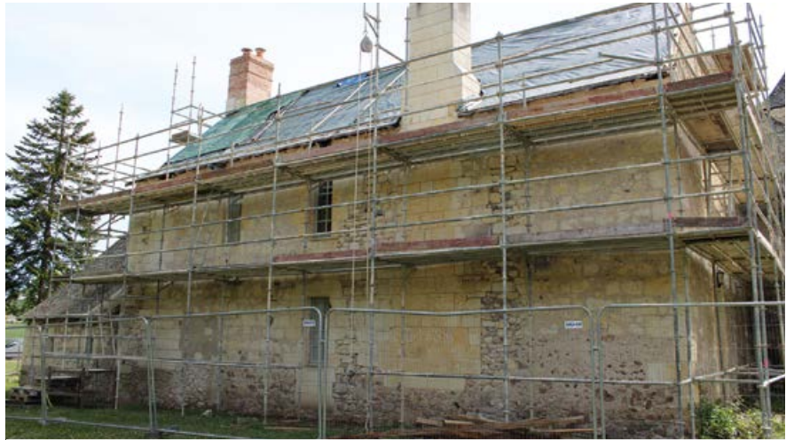
Ces travaux d'ampleur permettent de sécuriser l'ensemble de l'édifice.
