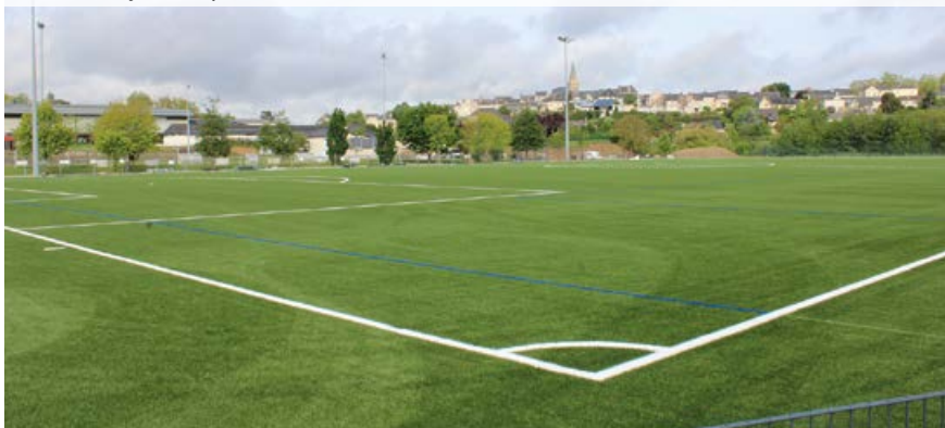
Le terrain synthétique en fin de travaux.
