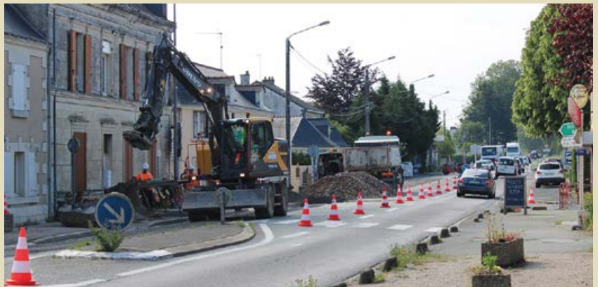
Sur la RD 761 des travaux vont se poursuivre entre septembre et novembre.
