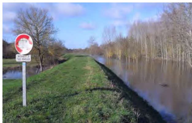
Rupture de la levée Gohier-Blaison-St-Sulpice
