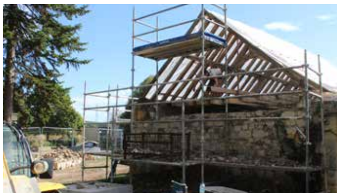
Le pignon pendant la phase démontage.
