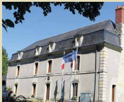
8 mois de travaux seront nécessaires pour cette rénovation.
