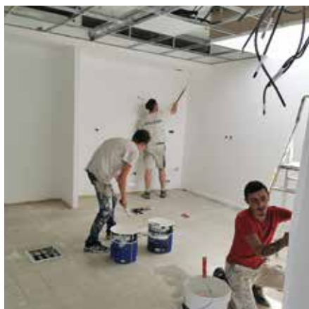
Le chantier s'est poursuivi cet été avec les travaux de sol et peinture.
