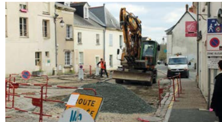
Les travaux pour la reprise de la voirie ont été menés au mois de mars.
