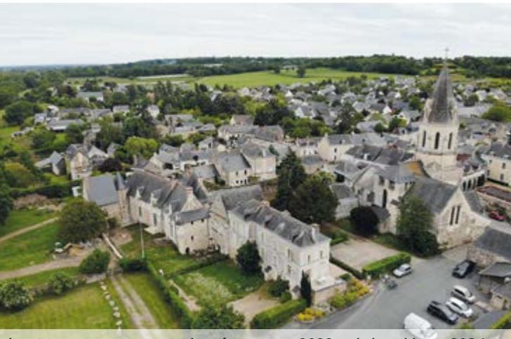
Les travaux concerneront les réseaux en 2023 puis la voirie en 2024.
